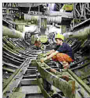
Cantiere del tunnel per la Tav
